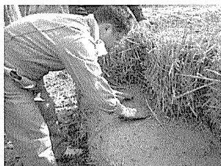
ベイル表面に 土を塗る作業 (試作品)
