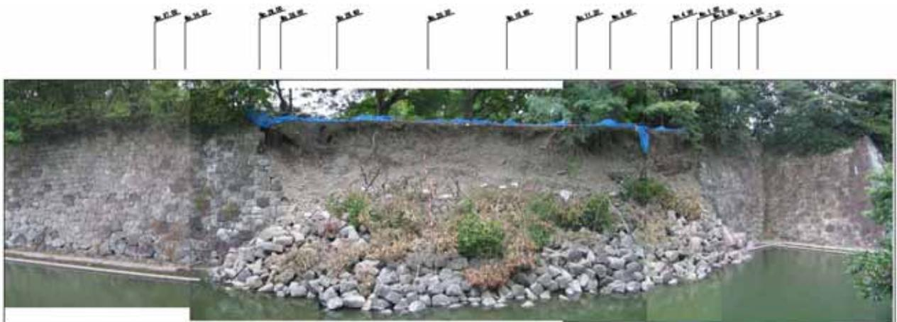
写真-2 崩壊した石垣
