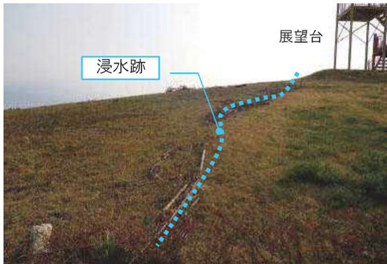
写真-7 築山の浸水跡
