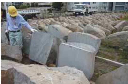
写真-3 新補石の型取りの様子、加工前の新補石 (22/06/11)
