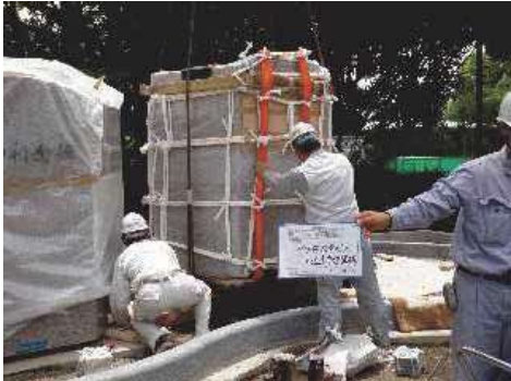
写真-8 慰霊碑のつり込み設置状況
