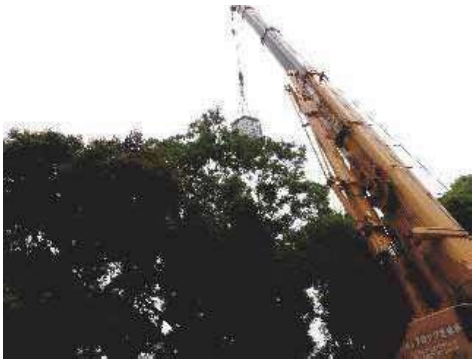
写真-7 周囲の樹木を傷つけないように慰霊碑を20m以上持ち上げての設置している状況
