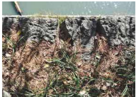
積石が天端石として用いられる箇所もある
