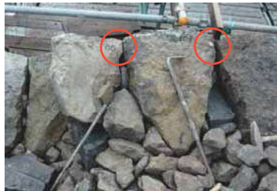
在石も概ね二番で合端は取れるが、控えの長さが不足することが多い 写真-6 合端の様子 (22/12/22)
