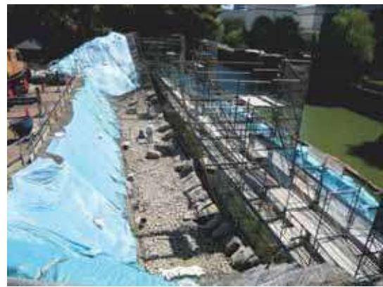
写真-2 丁張りの様子（22/08/30）
