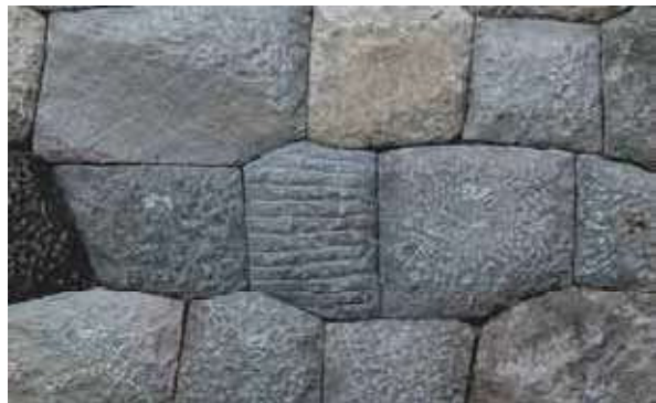
横方向のスジも往時を踏襲したものである 写真-4 ノミ切り仕上げ (23/02/23、23/03/15)
