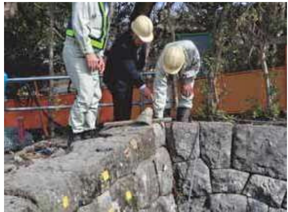
本工事での天端石の様子
