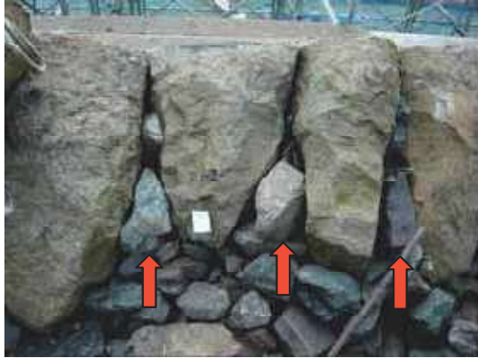
積石間の隙間を1石の胴飼石で埋めている
