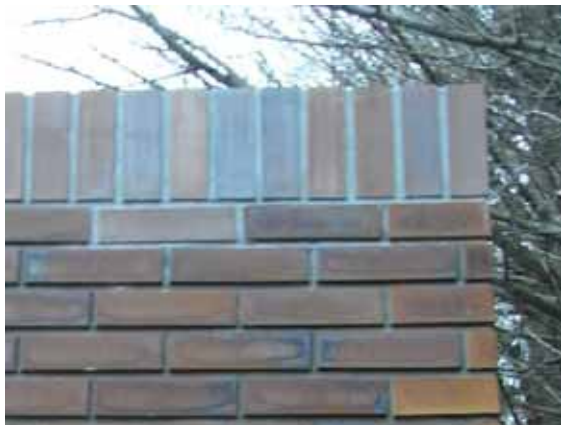
写真7.2 補修後 外壁タイル状況
