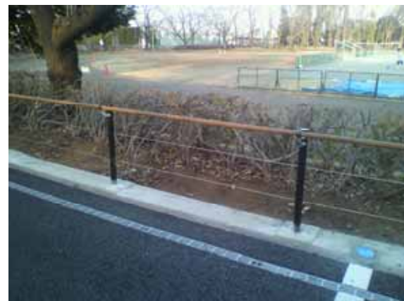
写真4 整備後 手摺状況
