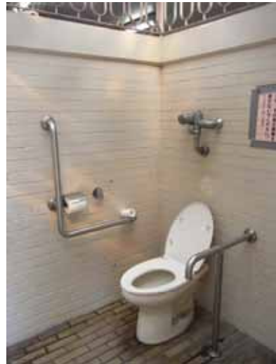
写真8.1 改修前 だれでもトイレ状況
