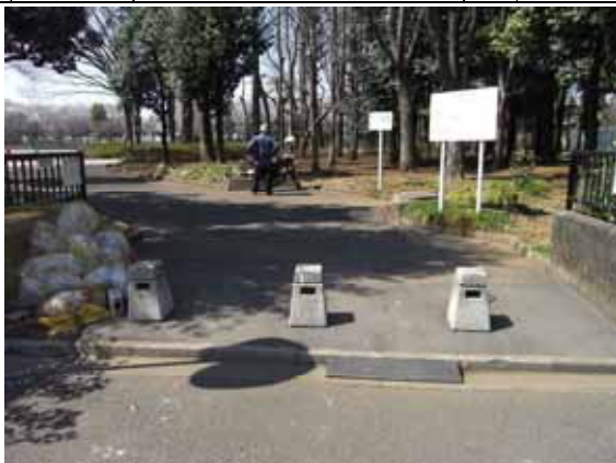
写真3.1 整備前 出入口状況
