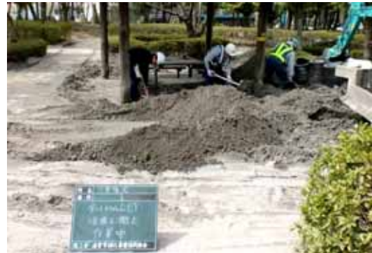
写真6 体積土砂撤去状況 (今川トリム公園)
