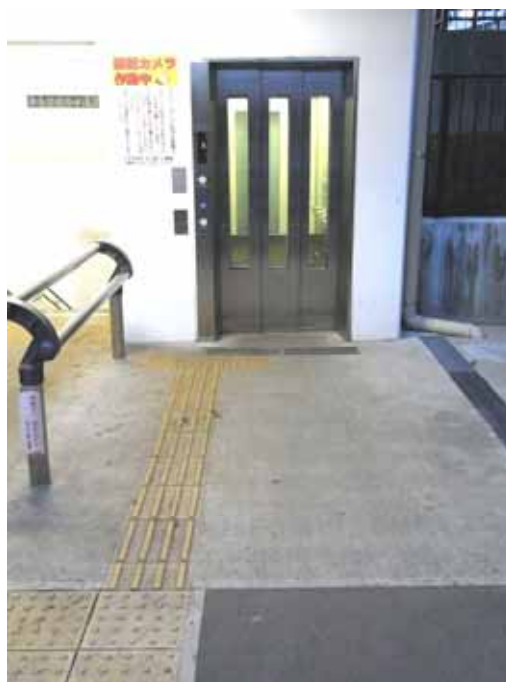
写真1 先に整備が行われた「鷹の台駅」から直結する地下通路からのエレベーターと誘導ブロック
