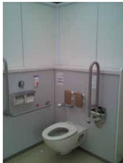
写真8.2 改修後 だれでもトイレ状況
