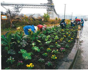
写真-25 フラワーロード 植栽作業の様子
