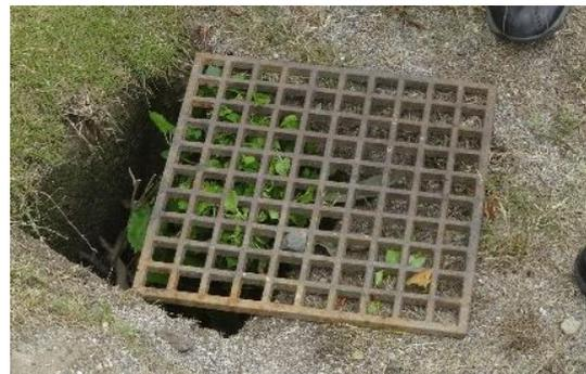
写真3 雨水枘のはずれ
