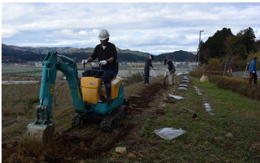
写真-11 掘削及び土と肥料の攪拌
