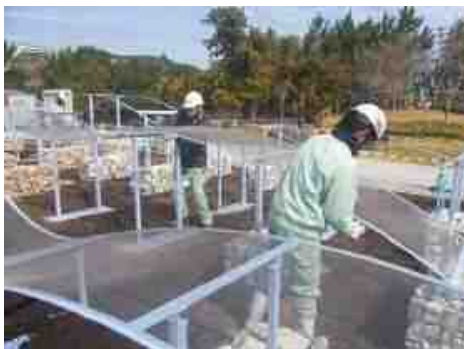
基盤の上に波となる金網を設置
