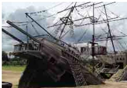
赤穂海浜公園の大型遊具（難破船）の再整備である。設置して28年経て老朽化や現在の安全基準を満たさないことなどから大規模な更新が必要とされた。更新にあたっては「公園のシンボル」としての継続的な利用も望まれていたことから、全てを破棄するのではなく使用できる材料は有効に活用し、耐久性に優れた材料を適材適所に使い分け制作された。安全性の向上や機能を追加しつつ、全体コストを抑えながら制作されたことが評価された。
