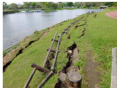
写真8 水際部の地割れ沈下
