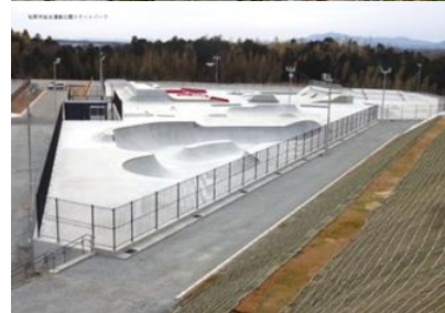
施工部門 松本市総合運動公園 スケートパーク
