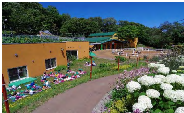
駐車場からエントランスに向かうスロープ
