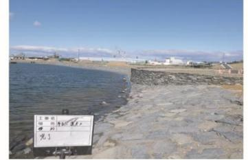
鎮魂の場にふさわしく静謐な空間を創出するために使用造物の素材や周囲との色彩調和など検討点が多々あり、三者協議や施工検討会を通じ一つずつ解決していく事を心掛けた。特に善海田池護岸から人工水面周囲で使用する石材については限られた遺構資材である地元原産の「稲井石」を使用する事や自然水面から人工水面へとスムーズな視界移動となるよう配慮する必要があった。高度な石積みの技術と地域性を活かす為に地元石材組合からの支援を受け、原産石材に最も精通する業者の選定と試験施工を実施して積み方の確認や景観を事前認識として共有する事ができた。人工水面については約500㎡の循環型レベル水域であり、水深は20cmで全体的に外周水路への越流構造となっている。別工事であった献花台と併設する構造でもあった為、主要な検討事項として献花台水域部の防水処理等が課題となり、最適な工法を提案書作成の上で考査し、最も効率的な施工方法として採択していただく事ができた。
