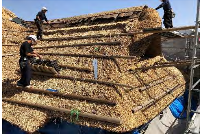
旧円通寺客殿 屋根工事（茅葺）
