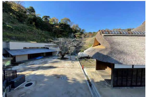
管理休憩棟と旧円通寺客殿
