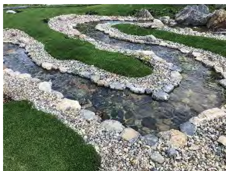
曲水部目地表面に川砂を撒いた様子
