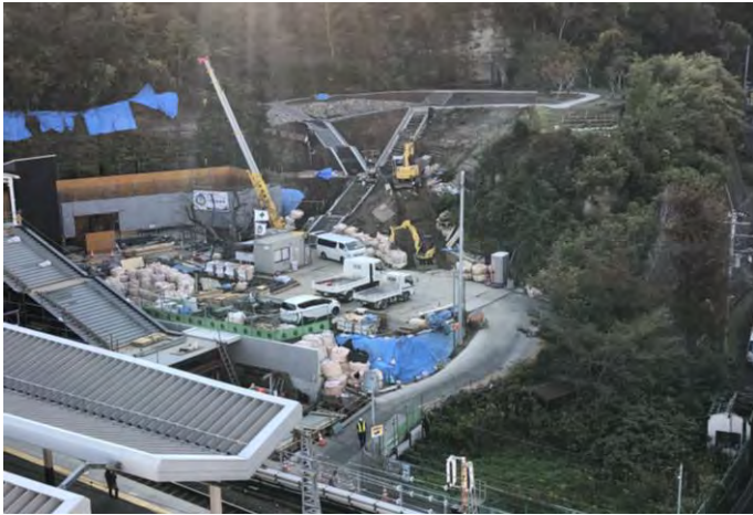
工事中の様子
