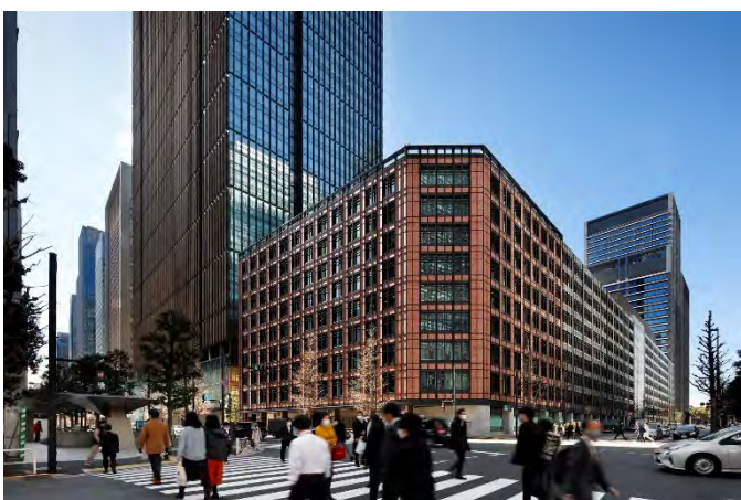
改修後の大手町ビル外観。
