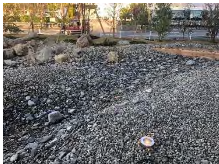
溜池砂利敷状況
