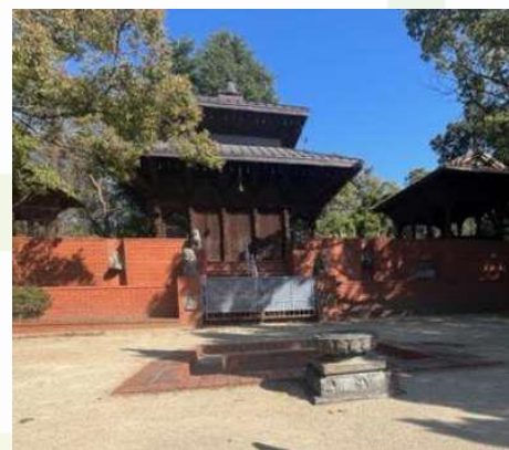
現在の庭園（ネパール庭園） (出典：大阪市撮影)
