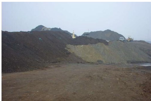
建設残土で造成中のみはらしの丘
