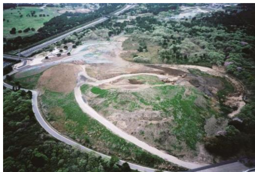
残土搬入が進みその形が現れた丘
