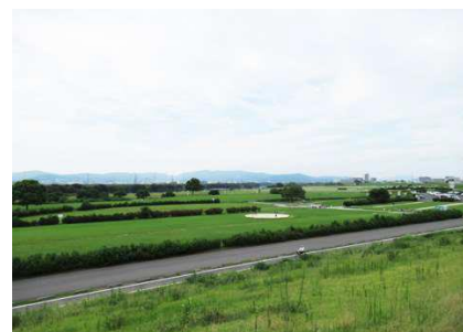
太間地区の全景
