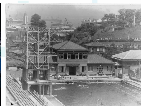
横浜プール(現元町プール) 昭和10(1935)年横浜市史資料室所蔵
