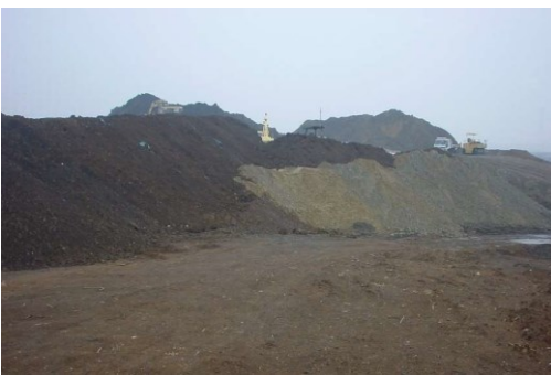
建設残土で造成中のみはらしの丘
