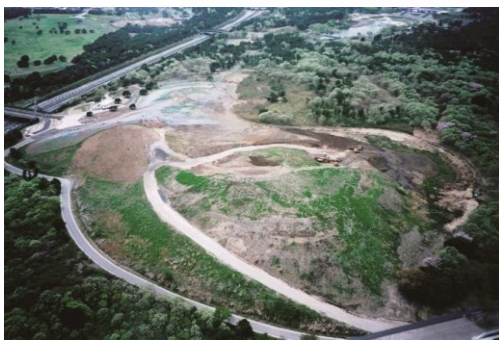
残土搬入が進みその形が現れた丘
