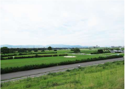
太間地区の全景
