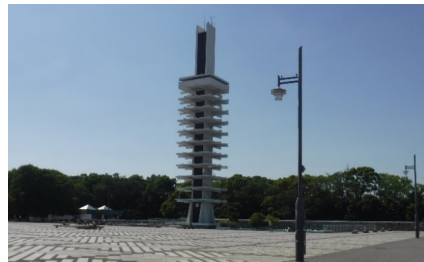
管制塔（駒沢オリンピック公園）【世田谷区】 本施設は、電気、電話、給水塔の設備機能を集中させ、公園の管理を経済的かつ合理的に実施できるようにするとともに、公園の中央広場の焦点・シンボルとして、オリンピック開催を記念するために整備された。
