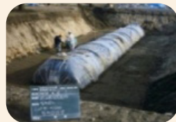
耐震性貯水槽 災害によって水道等のライフラインが断絶した場合の当面の飲料水や消防用水の確保をする施設
