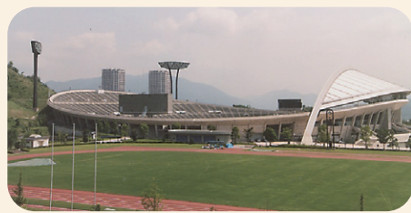
陸上競技場(広島広域公園)【広島市】
