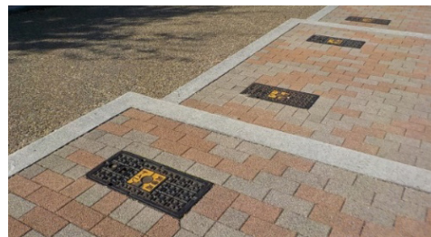
防災公園（神戸震災復興記念公園）【神戸市】 防災公園街区事業により整備を行い、公園内には防災施設として災害用仮設トイレ、ソーラー・風力照明灯、地下貯水槽、非常用自家発電装置等が整備された。
