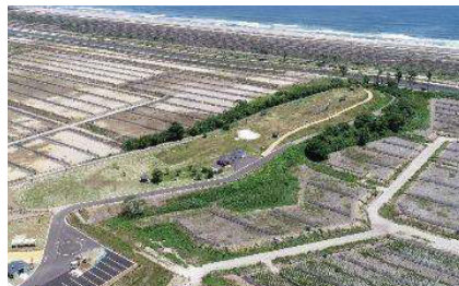
避難の丘（海岸公園）【仙台市】 津波来襲時の海岸公園地帯の避難者を対象とする一次避難場所として、震災がれきや津波堆積土を利用した築山を設置している。
