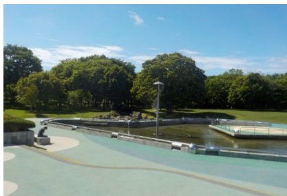
多目的広場等（市民文化公園）【苫小牧市】 都市的な環境と都市イメージの向上を図ることによる魅力ある都市づくりの拠点として整備され、市民のふれあいや安らぎの場となっている。
