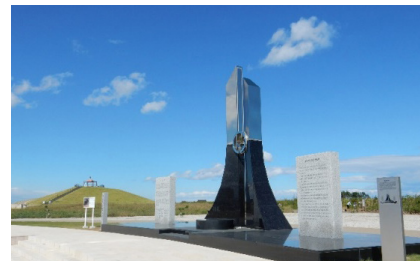
千年希望の丘（千年希望の丘相野釜公園）【岩沼市】 津波の力の減衰を目的として一時避難場所とそれらを繋ぐ避難誘導路を整備。震災廃棄物を使用した築造や集落跡地の遺構保存によりメモリアル公園としての機能を持っている。
