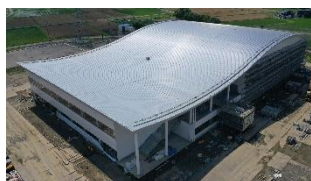
避難所となる体育館の整備
