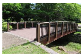
老朽化した公園施設の改修
