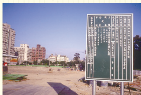
第14号・第15号公園の工事開始（1997年、越澤明撮影）写真は15号公園。奥の遠方が14号公園。左手遠方の建物群は公園道が廃止された場所に建設された。黄世孟教授（建築学会理事長）が案内。
