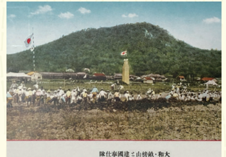
建国奉仕隊が造成工事を行なった。
